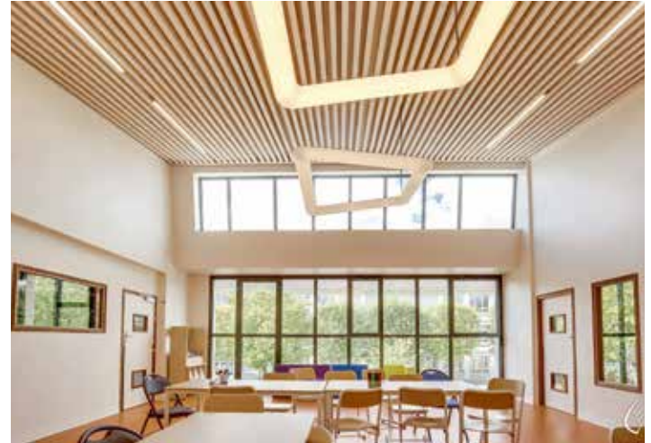
Schule in Rueil Malmaison. Die Deckenkonstruktion verbindet das Nützliche mit dem Angenehmen. Tragende Holzdecke O'Portune® mit schallabsorbierender Unterseite (© CBS-CBT)
