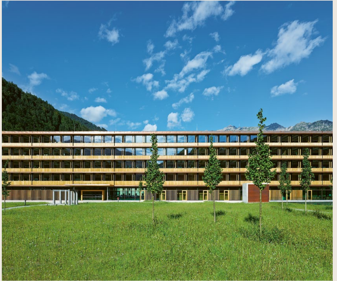
Illwerke Zentrum Montafon, Vandans, A
