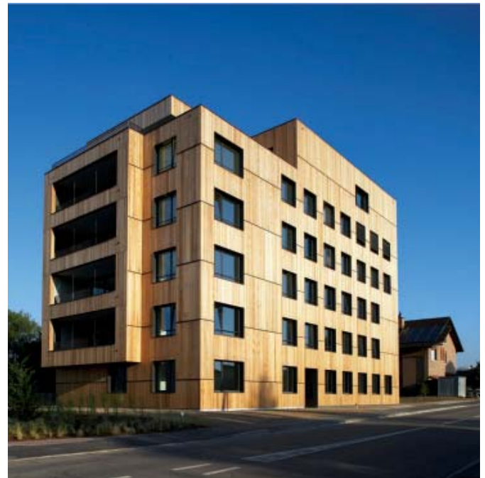
Mehrfamilienhaus, Zug, Schweiz.
