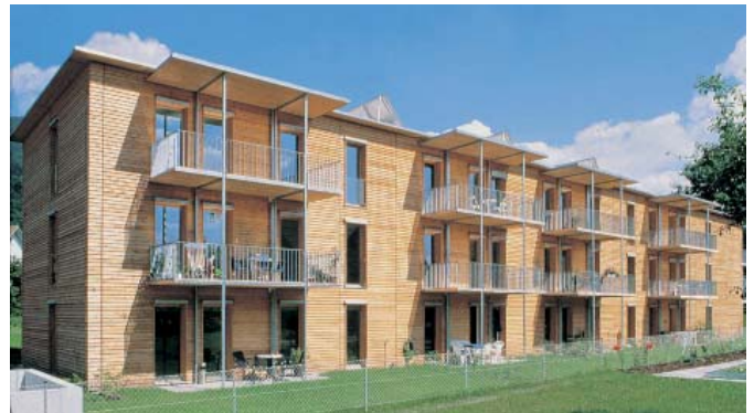
Immeuble d'habitations Ölbündt, Dornbirn, Vorarlberg, Autriche.
