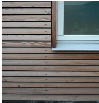
(Illustration D) Le joint négatif permet le séchage (détail d'embrasure)
