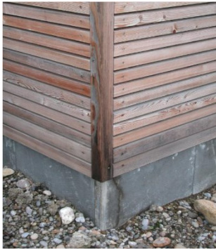
(Illustration C) Protéger le bois de bout (détail d'angle)
