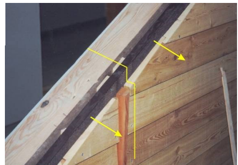
(Illustration B) Assurer une bonne ventilation de la face arrière
