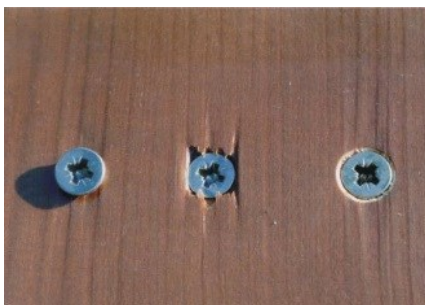
(Illustration F) Eviter l'infiltration d'eau par une fixation propre sans bavure ou éclat.
