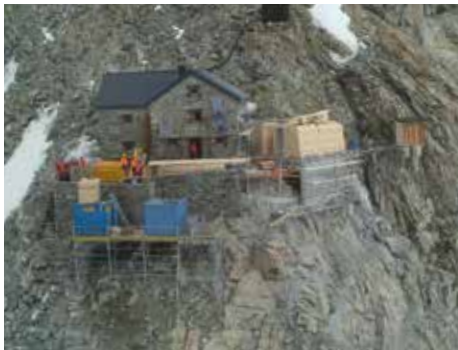
Annexe de la cabane de la Dent Blanche (VS) 2015 – CAS section Jaman © Studio de Kalbermatten Architectes – Sion
