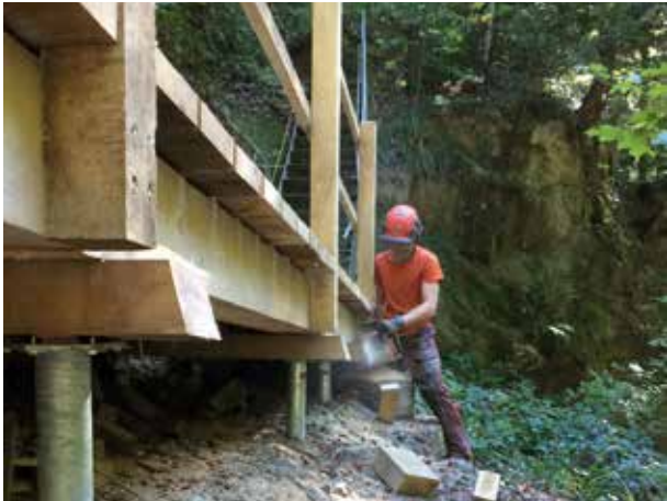
Photos 1-3 : vues des vis implantés dans le sol source (© Krinner Suisse)
