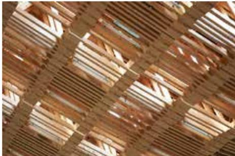
Le plafond du bâtiment Arch\_Tec\_Lab de l'ITA à l'EPF Zurich est réalisé en lames simples clouées. L'ensemble a été modélisé numériquement par Gramazio Kohler Research, pour garantir l'emplacement des connecteurs selon la géométrie. (Photo : © Corinne Cuendet)
