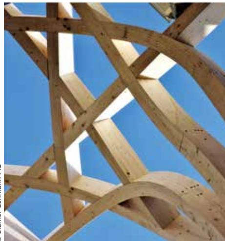
Avec sa façade en brique clinker qui s'intègre harmonieusement aux rangées de maisons qui l'entourent, on n' imagine pas l'intérieur du bâtiment avec sa forêt de piliers en bois qui constituent la structure de la nouvelle mosquée de Cambridge. Trente colonnes conçues comme des arbres, dont les troncs se transforment en branches aux improbables formes d'arabesques, constituent le plafond. Pas moins de 2746 éléments
