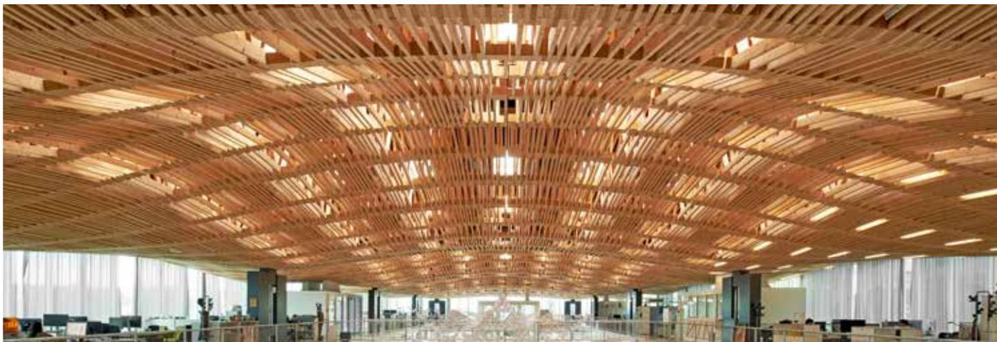
Pour le bâtiment de l'Arch\_Tec\_Lab de l'Institut de technologie en architecture (ITA), Gramazio Kohler Research, la chaire d'architecture et de conception numérique, a mis au point un nouveau type de construction robotique pour la toiture à partir d'éléments en bois. Les résultats de ses recherches qui intègrent conception, analyse structurelle et données de fabrication, sont condensés et appliqués à l'échelle architecturale. Il en résulte une structure
