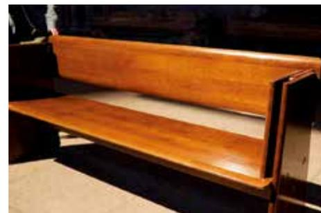
Assemblages bois-bois remis au goût du jour pour les bancs de la cathédrale de Lausanne. Grâce à ce système d'assemblage développé par l'Ibois à l'EPFL, les bancs sont démontables et remontables, stockables à plat. (Photos : © Jamani Caillet)
