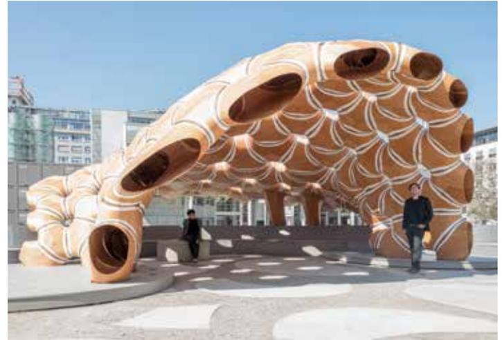
L'étude de la morphologie du développement de la carapace d'un oursin plat, le « dollar des sables » a conduit une équipe interdisciplinaire d'architectes, d'ingénieurs, de biologistes et de paléontologues à développer un système de construction en bois à deux couches s'inspirant de la carapace de cet animal. De fines bandes de placage en hêtre de 3 à 5 mm d'épaisseur ont ainsi été laminées pour former des panneaux
