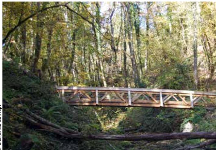
La passerelle et le ponton du Rou-lave sont des ouvrages pour piétons et cyclistes réalisés en chêne issus des forêts genevoises. D'une portée de 11 et 12,5 mètres ces deux éléments sont constitués chacun de deux poutres triangulées en bois lamellé-collé de chêne d'une hauteur statique de 1 mètre, reliées par un tablier en lames ajourées en chêne massif. Des câbles tendus font office de garde-corps, laissant la
