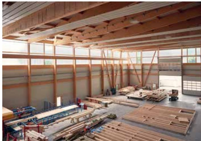
La halle de 55 m × 80 m a été conçue pour la production d'éléments préfabriqués. D'une hauteur de 16 m au faîtage, elle est constituée de portiques en lamellé-collé de 55 mètres de portée sur trois appuis. L'appui central est réalisé par une poutre treillis longitudinale qui soutient les charges de la toiture et des ponts roulants ainsi qu'une passerelle d'accès et de visite. Cet élément central délimite deux bandes de production
