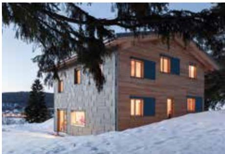
Cabane R, dont la façade ouest est réalisée en panneaux métalliques pour être plus résistante à la pluie battante.
