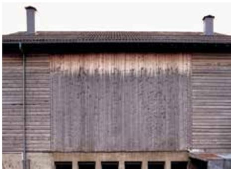
Vieillessement différencié du bois sous un avant-toit, selon le sens de pose des lames. / Cedotec
