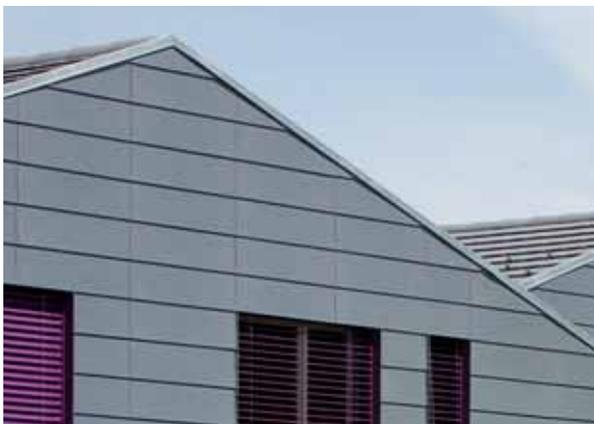
Plâtre armé de fibres 15 mm
