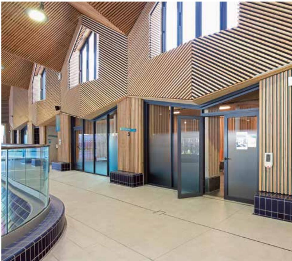
Fig. 3 : Panneaux acoustiques noEcho® Lames bois ajourées et couche d'isolation acoustique (© Walter Babic | CBS-CBT)
