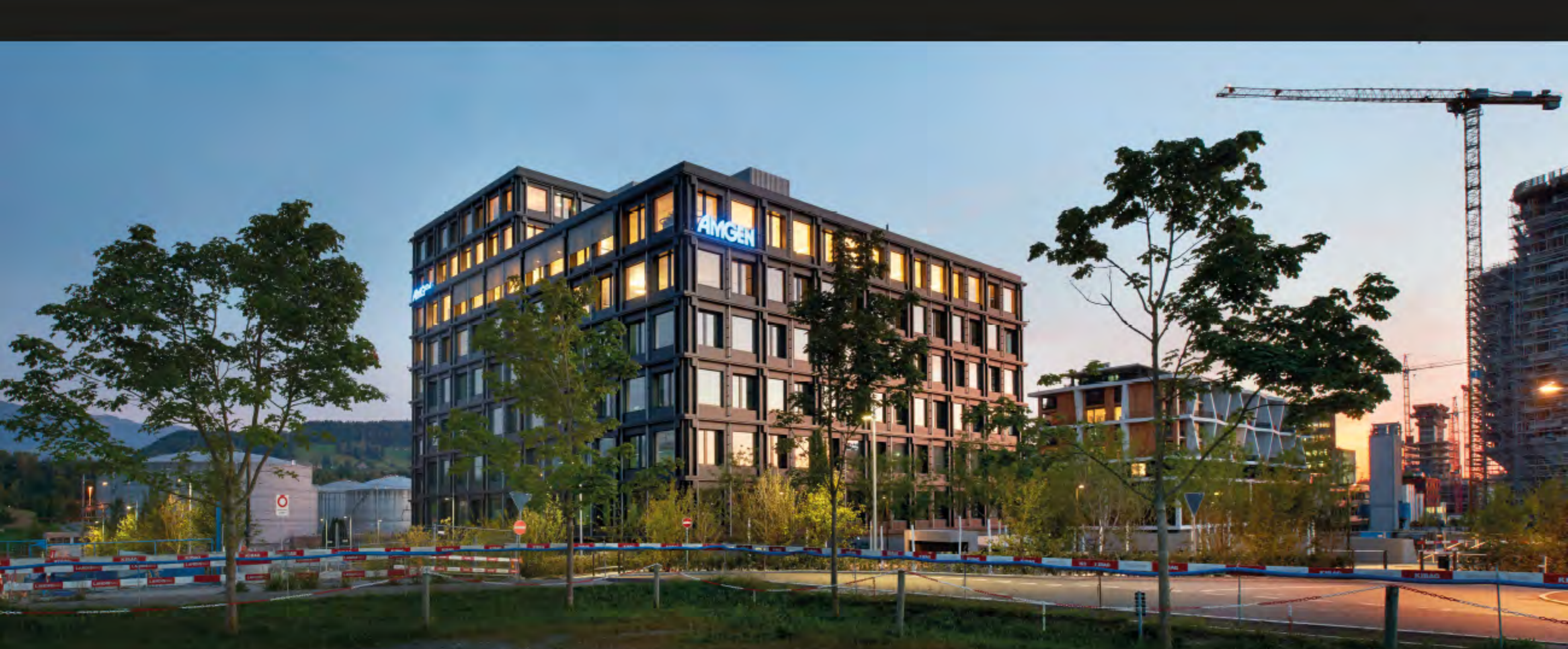
Immeuble de bureaux Suurstoffi 22, Risch-Rotkreuz (ZG)
