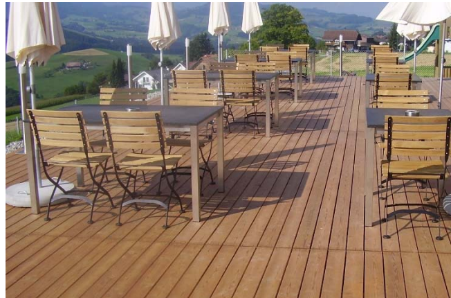
Figure 3.4-4: Lame de plancher en mélèze comme revêtement de sol à l'extérieur.
