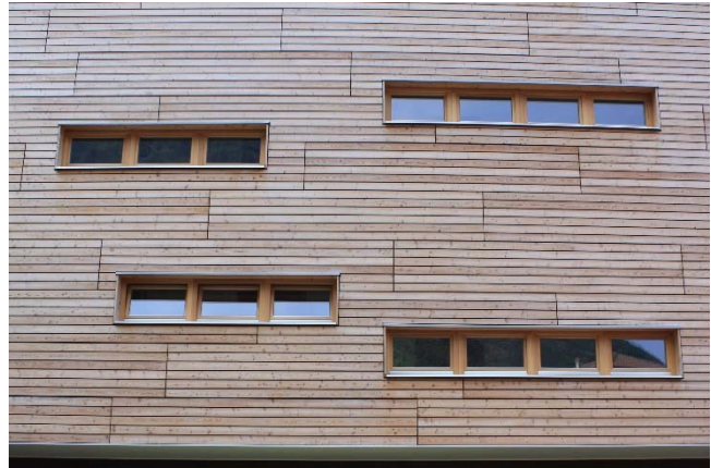
Figure 3.2-4: Lambris de mélèze comme revêtement de façade.
