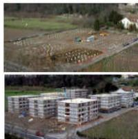
Grâce au faible poids des structures en bois, les coûts des fondations sont réduits.
