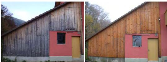
Homogenisierung der Farbe durch Hochdruck Wasserreinigung an einer Fichtenfassade in Péry (JU) (Foto : BFH AHB)
