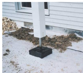
Abbildung B+C: Spritzwasserzone + Stützen mind. 30 cm
