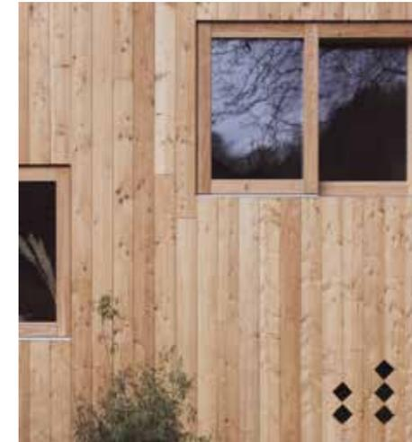
aus «kleinen Welten» lässt das Haus geräumiger erscheinen, als es in Wirklichkeit ist. Verschiebbare Öffnungen rahmen den Blick je nach Standort. Die gesamte Tragstruktur, Böden, Einbauten, Trennwände, Dach und Mobiliar sind aus Brettspertholz aus heimischer Fichte hergestellt. Ein Holzofen sorgt für Wärme und ergänzt bei der ersten Winterrkälte den Pellets-Heizkessel.
