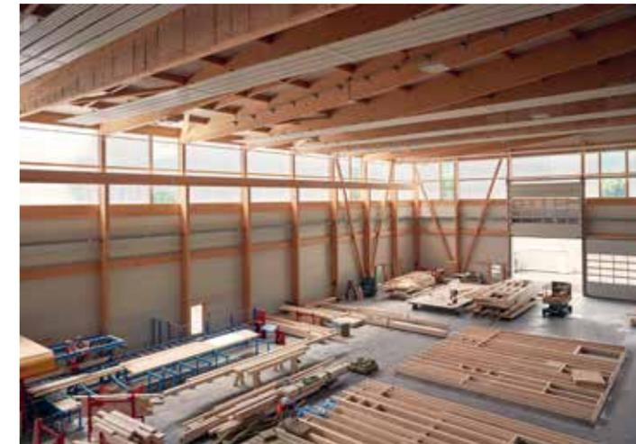
Die 55 × 80 m messende Halle wurde für die Produktion von Fertigteilen konzipiert. Mit einer Höhe von 16 m bis zum First besteht sie aus Brettschichtholzbindern von 55 m Spannweite auf drei Stützen. Die mittlere Abstützung besteht aus einem längs verlaufenden Fachwerkträger, der die Lasten des Daches und der Rollkrane trägt. Integriert ist ein Zugangsteg für Besichtigungen. Dieses zentrale Element teilt den Raum in zwei parallele
