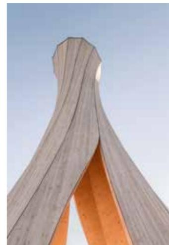
Der Urbach-Turm ist eine von 16 für die Remstal-Gartenschau 2019 erstellten Installationen. Es handelt sich um das weltweit erste Bauwerk aus selbstformenden grossformatigen Bauteilen aus Holz und beruht auf einem neuartigen Prozess für komplex geformte Holzkomponenten. Im Gegensatz zu den bislang üblichen Methoden bei der Herstellung von gekrümmtem Holz, die aufwendige und energieintensive mechanische Prozesse
