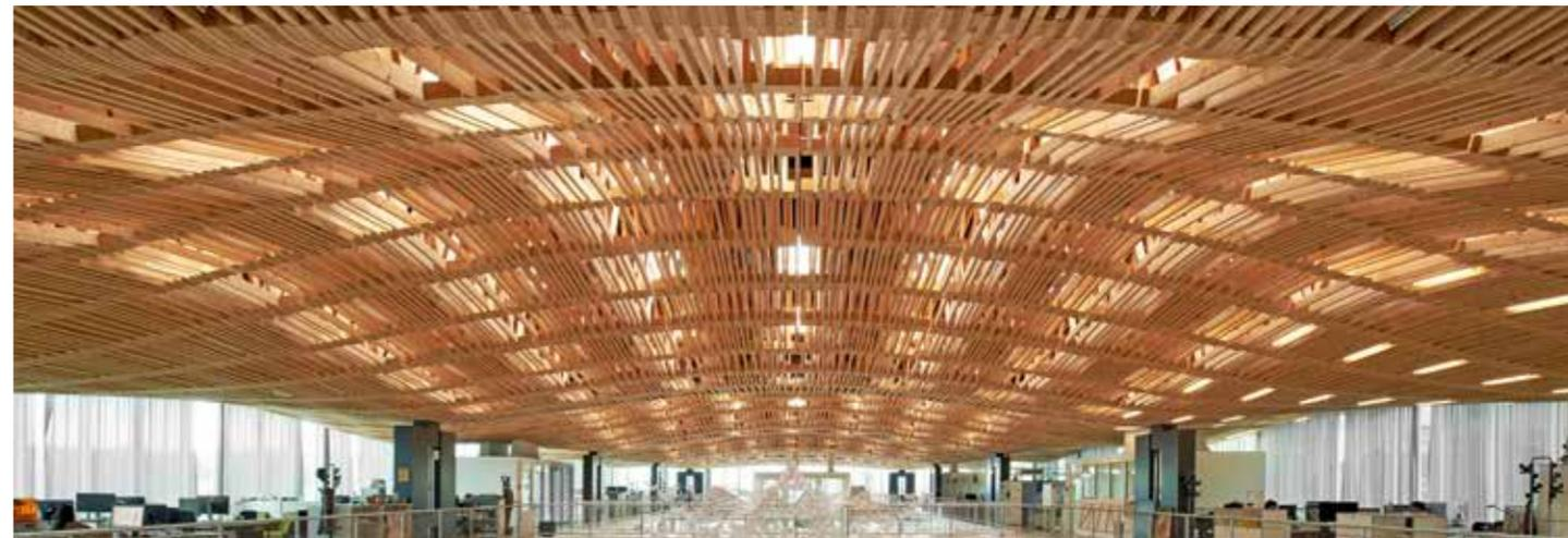
Das Gebäude des Arch\_Tec\_Lab für das Institut für Technologie in der Architektur (ITA), Gramazio Kohler Research, am Lehrstuhl für Architektur der ETH Zürich und für digitale Konzepte stellt einen neuen Typ der Roboterkonstruktion für ein Dach aus Holzelementen dar. Die Ergebnisse der Forschungen, die Konzeption, Strukturanalyse und Herstellung zusammenführen, finden hier ihren architektonischen Ausdruck.
