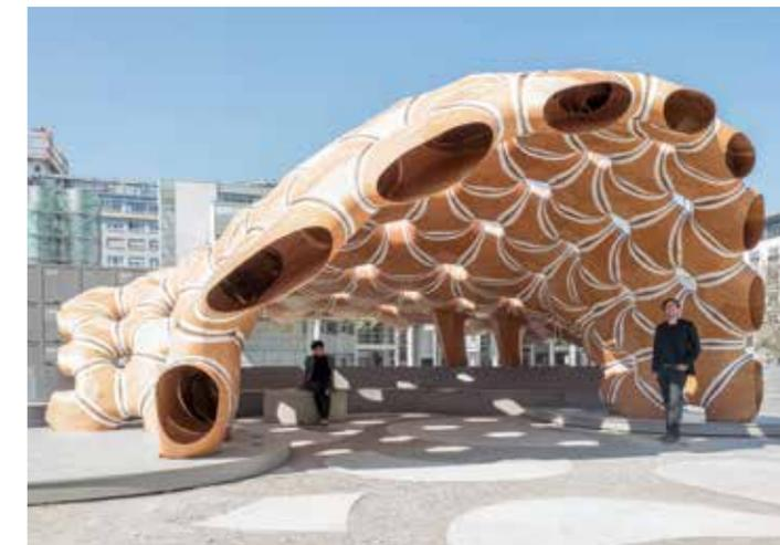
Untersuchungen zur Gestalt des Plattenpanzers eines Seeigels (Sanddollar – *Clypeaster humilis*) regten eine interdisziplinäre Gruppe von Architekten, Ingenieuren, Biologen und Paläontologen dazu an, ein Konstruktionssystem mit einer zweilagigen Holzstruktur zu entwickeln, das sich am Äusseren dieses Tiers orientiert. Dünne Furnierstreifen wurden zu dünnen, 3–5 mm starken Sperrholzplatten laminiert.
