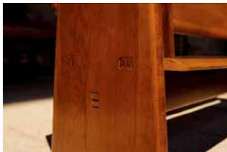
Holz-Holz-Verbindungen an den Kirchenbänken der Kathedrale Lausanne. Sie können je nach Bedarf gefügt oder wieder gelöst werden. Dank diesem vom IBOIS der EPF Lausanne entwickelten System lassen sich die Bänke leicht montieren und wieder demontieren und flächig lagern. (Bild: © Jamani Caillet)
