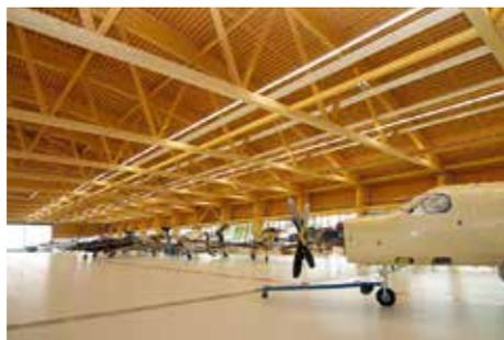
Weitgespanntes Tragwerk – Pilatus-Flugzeugwerke, Stans (Bild: © Prix Lignum 2009)
