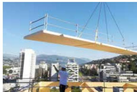
Baustelle des «Palazzo Nice Méridia», Versetzen der Deckenplatten grosser Spannweite aus Brettspertholz (Bild: © CBS-Lifeteam)
