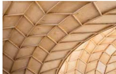
Die Bogenträger sind aus doppelwandigen, kastenförmigen Elementen (Holzplatten) erstellt. (Bild: © Valentin Bianchi, Brüssel)
