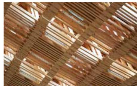
Die Dachstruktur des Arch\_Tec\_Lab für das ITA an der ETH Zürich ist mit einfachen genagelten Brettern konstruiert. Die ganze Struktur wurde durch Gramazio Kohler Research digital modelliert, und so wurden die Verbindungen in der Dachgeometrie definiert. (Bild: © Corinne Cuendet)
