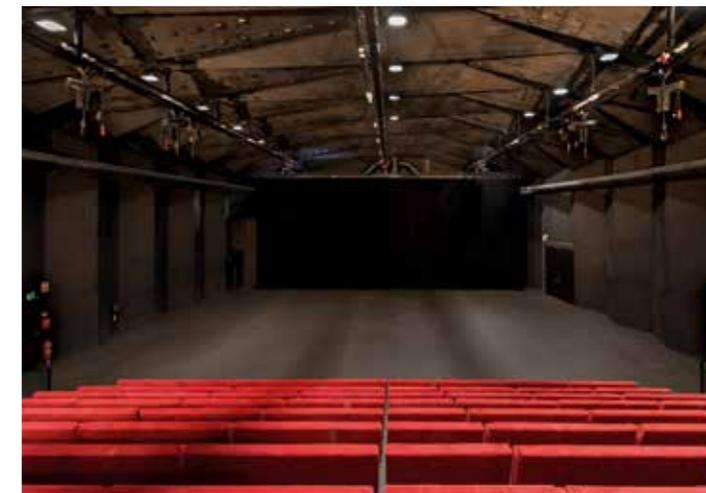
Die gestalterische und technische Herausforderung bei diesem Gebäude war es, eine Konstruktion vollständig aus Holz zu konzipieren (Tragwerk, Fassade mit Dämmung, ohne Verkleben oder Schrauben). Diese hat allen Ansprüchen an einen Theatersaal zu genügen. Zeitgemässe digitale Methoden erlaubten es, eine doppelwandige Holzkonstruktion für Wände und Dach zu realisieren. Die elf Binder bestehen aus Platten, die
