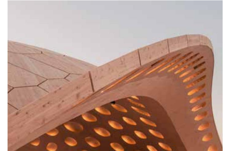
Das Institut für Computerbasiertes Entwerfen und Baufertigung (ICD) und das Institut für Tragkonstruktionen und konstruktives Entwerfen (ITKE) der Universität Stuttgart haben für die Bundesgartenschau 2019 (BUGA) in Heilbronn zwei innovative Holzpavillons entworfen. Die segmentierte Schalenkonstruktion basiert auf biologischen Prinzipien des Plattenskeletts von Seeigeln, die im Rahmen der Arbeiten an der Universität
