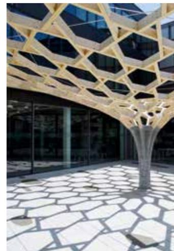
Die Konstruktion des «Future Tree» steht im Innenhof der baulichen Erweiterung für die Büros von Basler & Hofmann in Esslingen und zeigt das Potential parametrischer Planung. Mit dem von Gramazio Kohler Research entwickelten neuen Herstellungsprozess («Eggshell») wurde die Tragstütze aus Stahlbeton gegossen. In eine mit 3D-Print erstellte dünne Schalung wurde ein schnellhärtender Beton eingebracht, der mit
