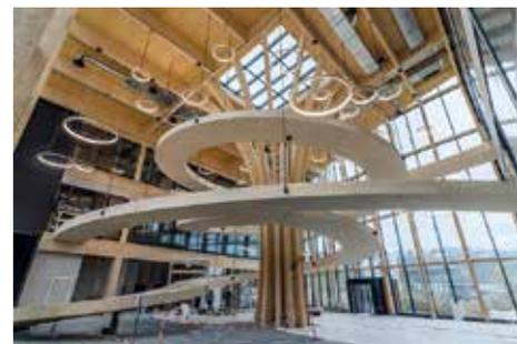
Struktur aus verformten Holzplatten für eine komplexe Raumform. Explorit in Yverdon-les-Bains (Bild: © Explorit)
