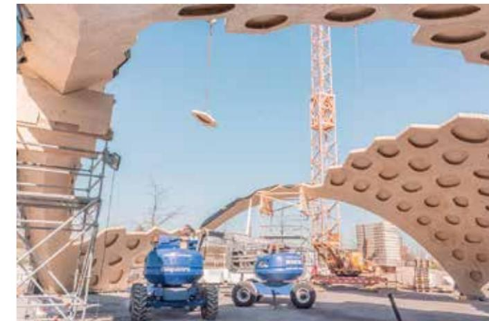
Vorfertigung und Montage dreidimensionaler Elemente – Pavillon BUGA. (© ICD/ITKE Universität Stuttgart)
