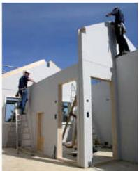
La construction à sec réduit le temps du chantier et permet ainsi une occupation rapide des bâtiments, réduisant d'autant les frais liés au crédit de construction.
