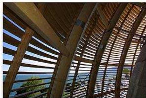
Per la costruzione del Palais de l'Equilibre sono stati impiegati 2500 m<sup>3</sup> di legno interamente prodotti nel nostro Paese. Questa quantità di legno equivale a meno di tre ore di crescita della foresta svizzera. La protezione dalle intemperie della facciata esterna è stata realizzata in legno Douglas svizzero recuperato dal padiglione elvetico dell'esposizione universale di Hannover del 2000.
