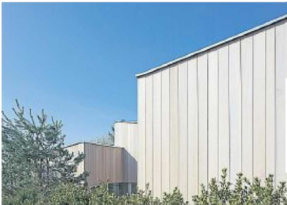
Bedingung fensterlos: Fassade aus Zedernholzplatten
