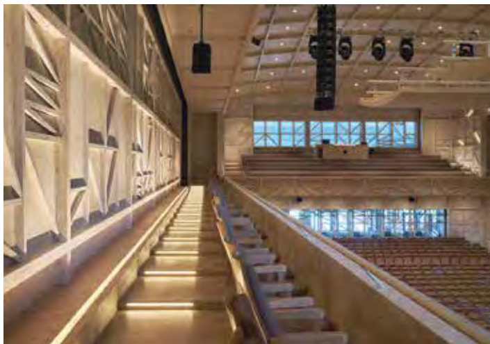
Salle de concert du Paul & Henri Carnal Hall du Rosey à Rolle conçu par Bernard Tschumi et réalisé par l'entreprise Schwab system, avec parois revêtues en panneaux OSB et éléments linéaires en surépaisseur pour parfaire l'acoustique de la salle. (© Corinne Cuendet)
