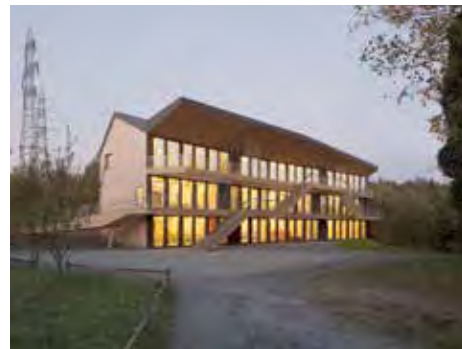
École Bois-Genoud, Crissier – Construction labellisée Label Bois Suisse, réalisée en 2011 – LOCALARCHITECTURE. (© Matthieu Gafsou)
