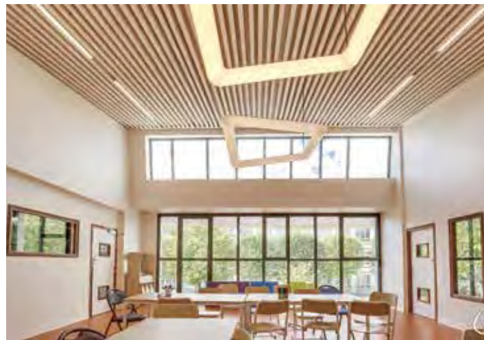
École à Rueil Malmaison – Un plafond qui marie l'utile à l'agréable. Dalle bois O'Portune® porteuse présentant une sous-face performante du point de vue de l'absorption acoustique. (© CBS-CBT)
