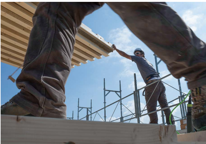
Aufrichtung vorgefertigter Elemente im Holzbau. [24]
