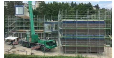
30.6.16 – Die letzten und abschliessenden Elemente werden versetzt
