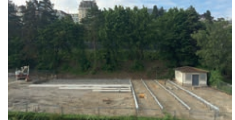
Juni 2016 – Versetzen der wiederverwendbaren Streifenfundamente
