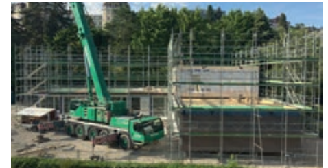
28.6.16 – Das Erdgeschoss ist erstellt
