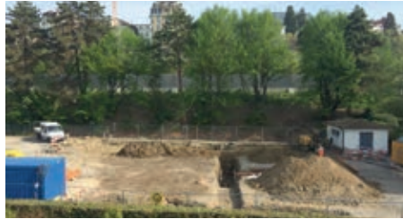
Mai 2016 – Erschliessung und Vorbereitung der Parzelle
