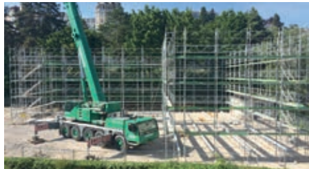
27.6.16 – Die Baustelle ist für die drei Montagetage vorbereitet
