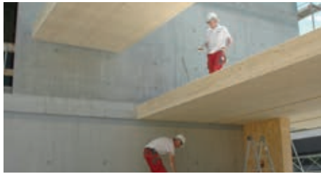
Vorgefertigte Kastenelemente für den Pavillon 5 in Estavayer le Lac
