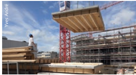
Vorgefertigte Hybriddecken-Elemente, Microcity, Neuenburg
