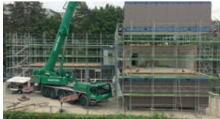
29.6.16 – Die Endmodule besitzen bereits eine Aussenverkleidung
