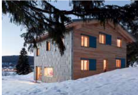
Die Westfassade dieses modernen Holzhauses trägt eine Schuppung aus Metallplatten, um den Schlagregen abzuwehren. Kunik de Morsier architectes Sàrl / Bild Eik Frenzel
