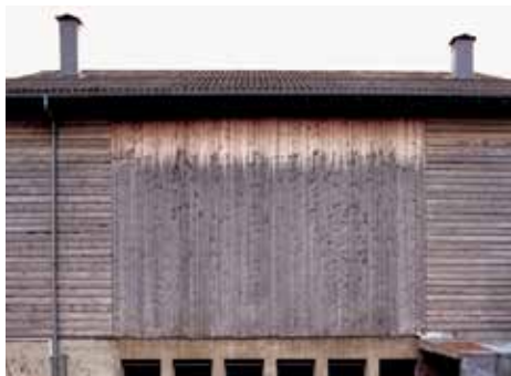
Unterschiedliche Alterung von Holz je nach Richtung der Bretter unter einem Vordach / Cedotec
