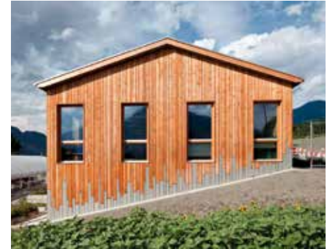
Spielerische Umsetzung des Bodenabstands im Sockelbereich. Cangemi Architekten, Chur / Bild Ralph Feiner
