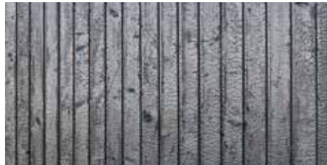
Fassade aus verkohlter Lärche (EcoNoir®) / FRD Architecture, Courtedoux / Bild Ets Röthlisberger SA, Glovelier
